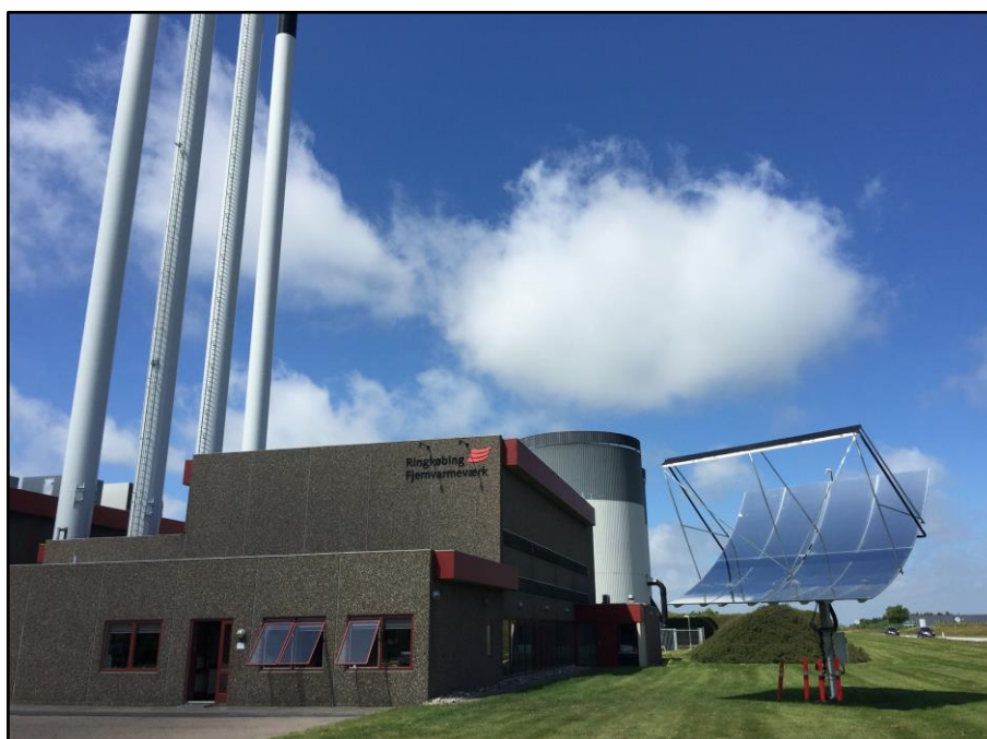
Foto: AURORA ved Ringkøbing Fjernvarmeværk
